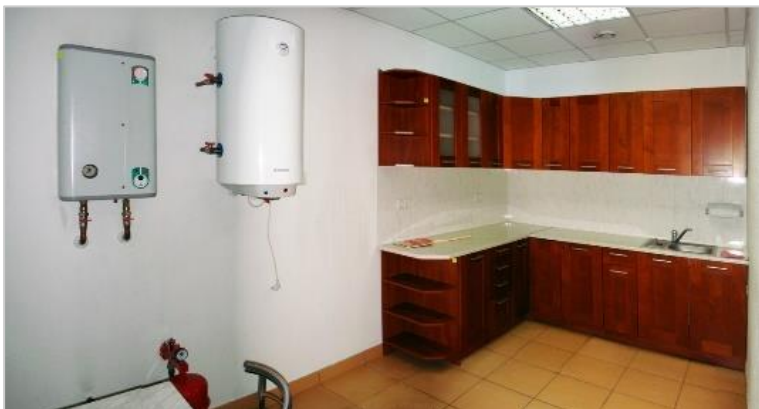
Інженерно-лабораторний корпус - Приміщення
