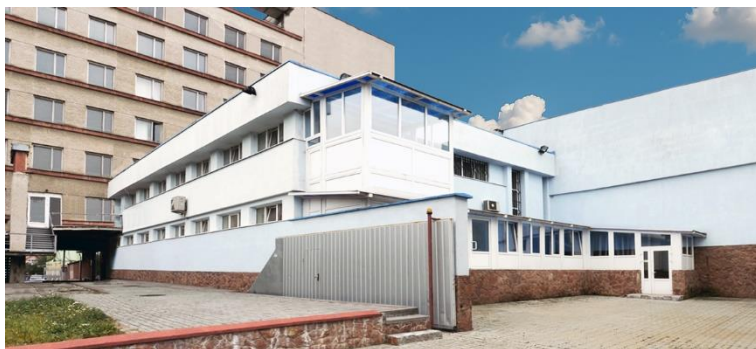
Корпус їдальні Вигляд ззовні
