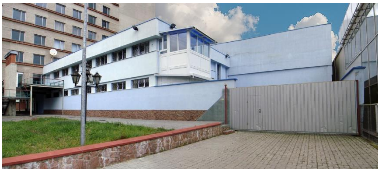
Корпус їдальні Вигляд ззовні
