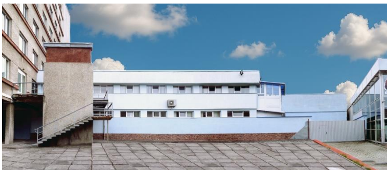
Корпус їдальні Вигляд ззовні
