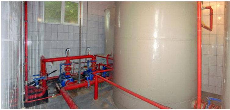
Корпус дослідного виробництва - Система пожежогасіння
